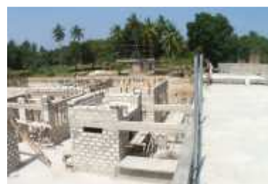
Foto: Projekt Schwarz-Weiß e.V. Rohbau der Klinik
